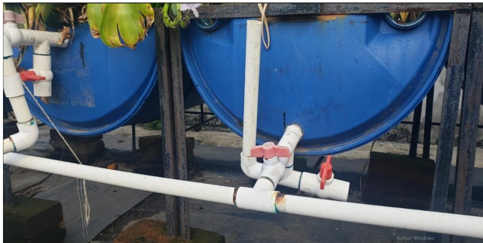
Figura 6. Detalles del sistema de toma de muestras y control de nivel del sistema.
