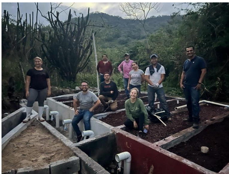
Figura 9. Estudiantes de posgrado COLVER en construcción de humedal de tratamiento en San José de Pastorías, Actopan, Veracruz.
